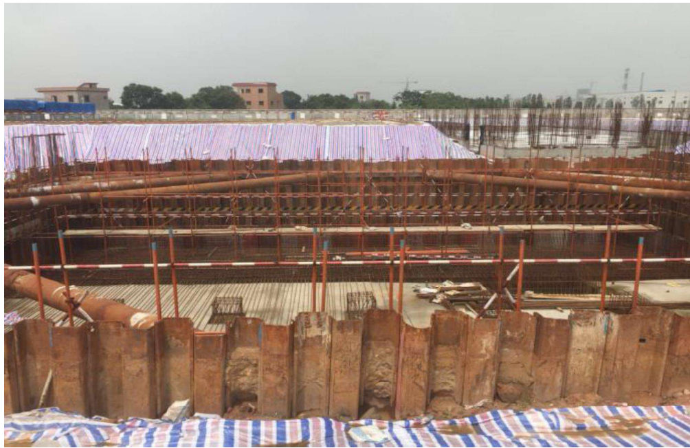
迴圈水泵房地下結構施工完成
