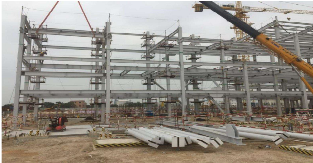
#2 主廠房鋼結構吊裝
