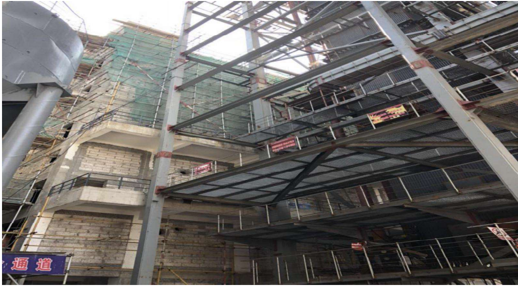
主廠房砌體施工
