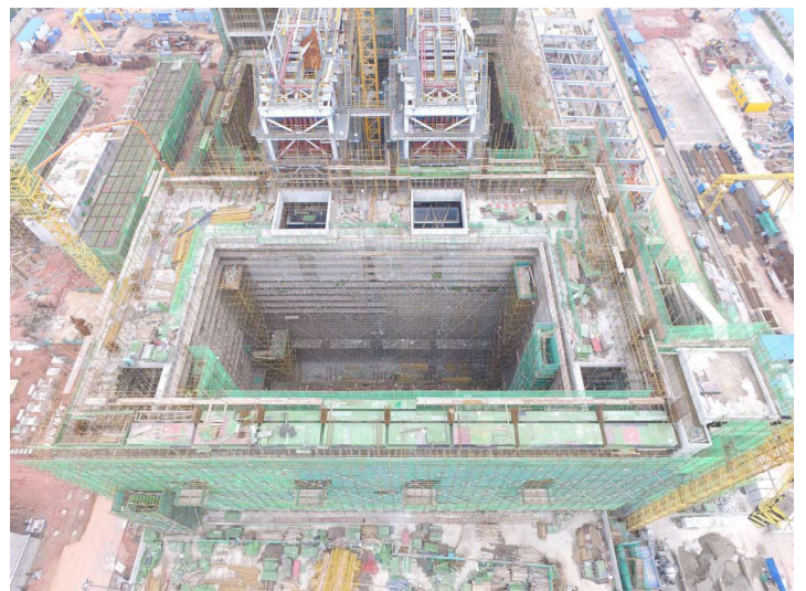
垃圾池結構施工
