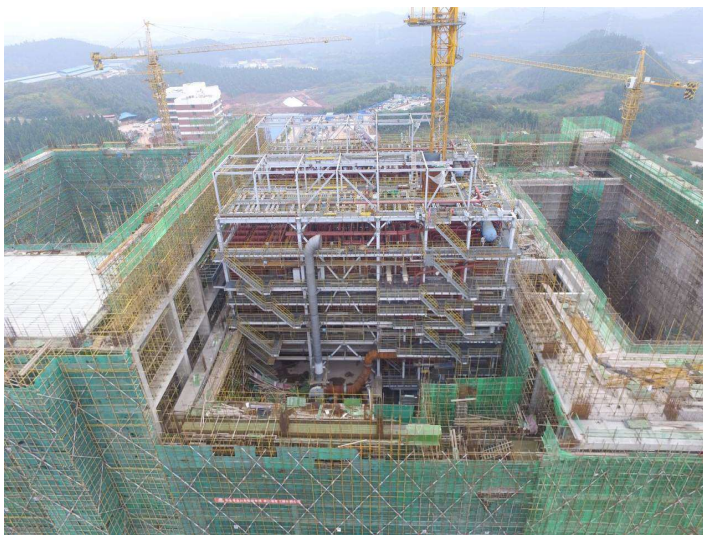
鍋爐鋼架安裝
