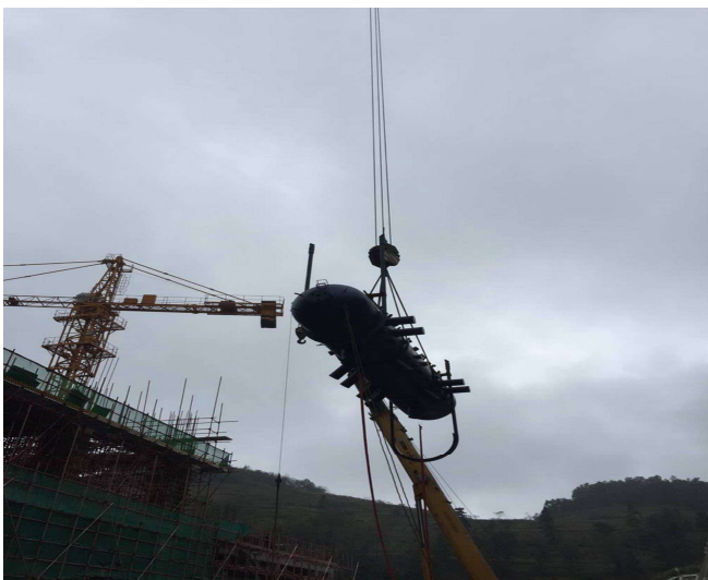
#2 鍋爐設備吊裝施工區域
