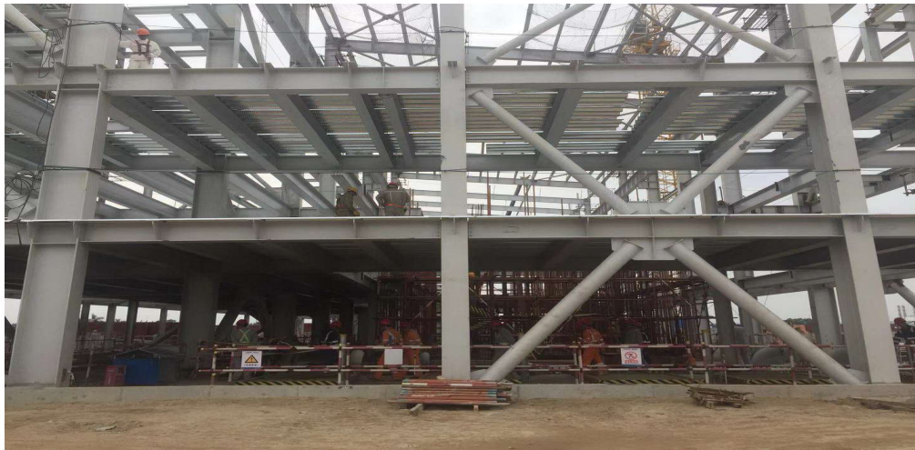
#1 主廠房汽機基座及平臺施工
