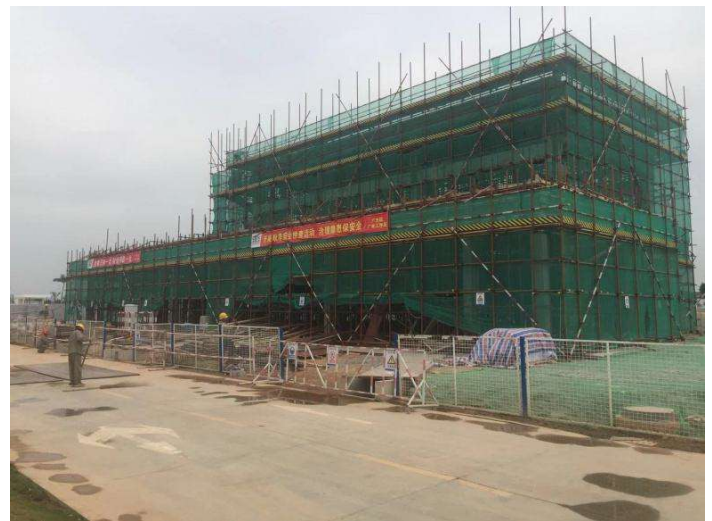
GIS 樓上部結構施工
