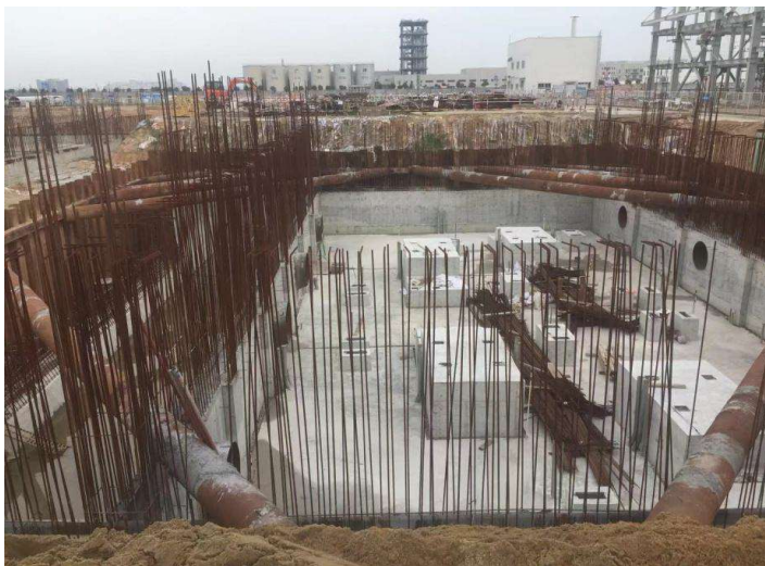
迴圈水泵房地下結構施工
