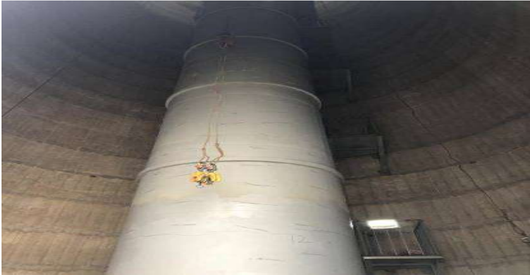
煙囪內筒安裝
