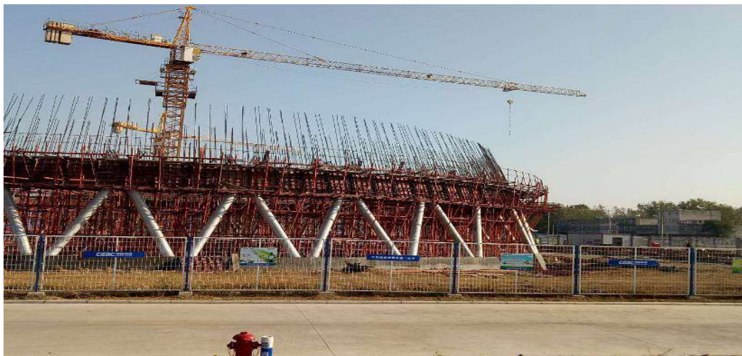
冷水塔底梁範本支護
