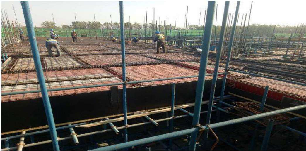
主廠房 7.95 米層鋼筋綁紮、範本支護
