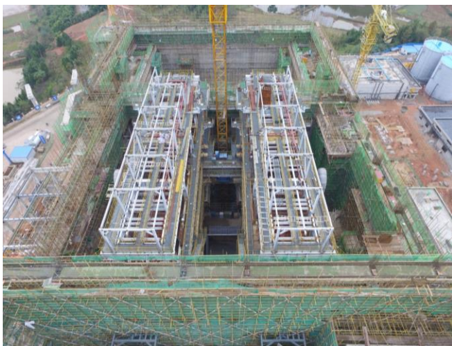
鍋爐鋼架安裝
