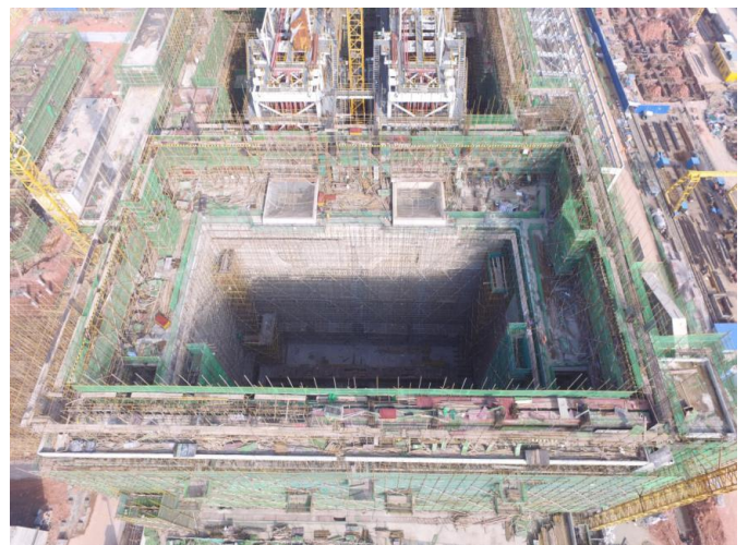
垃圾池結構施工
