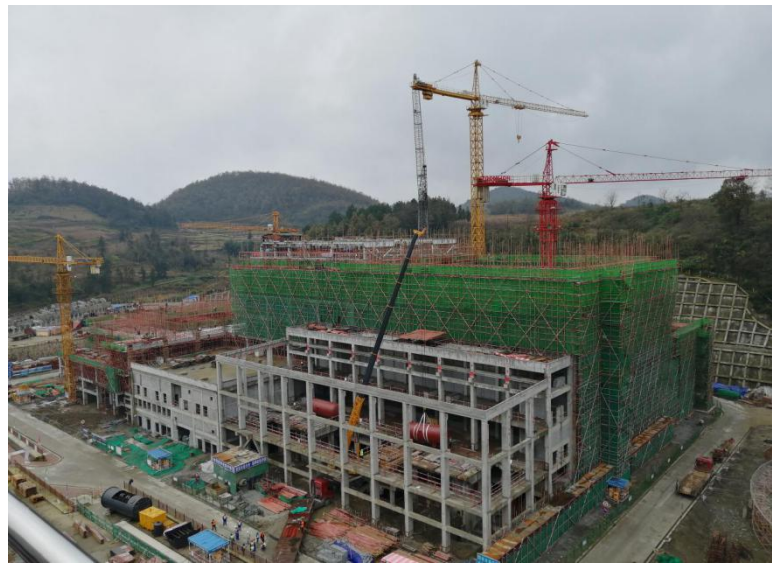
廠房區域形象進度
