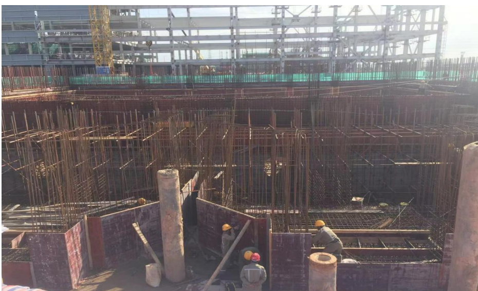
迴圈水泵房施工
