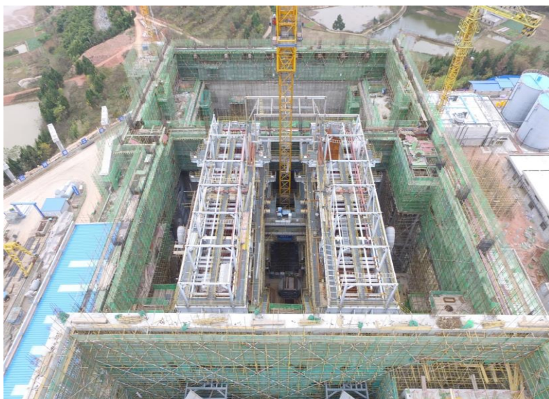
鍋爐鋼架安裝
