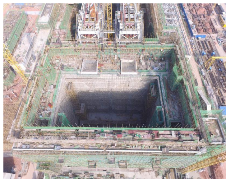
垃圾池結構施工
