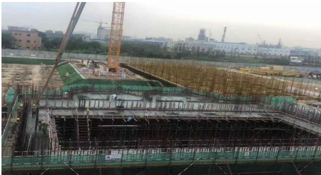
迴圈水泵房施工
