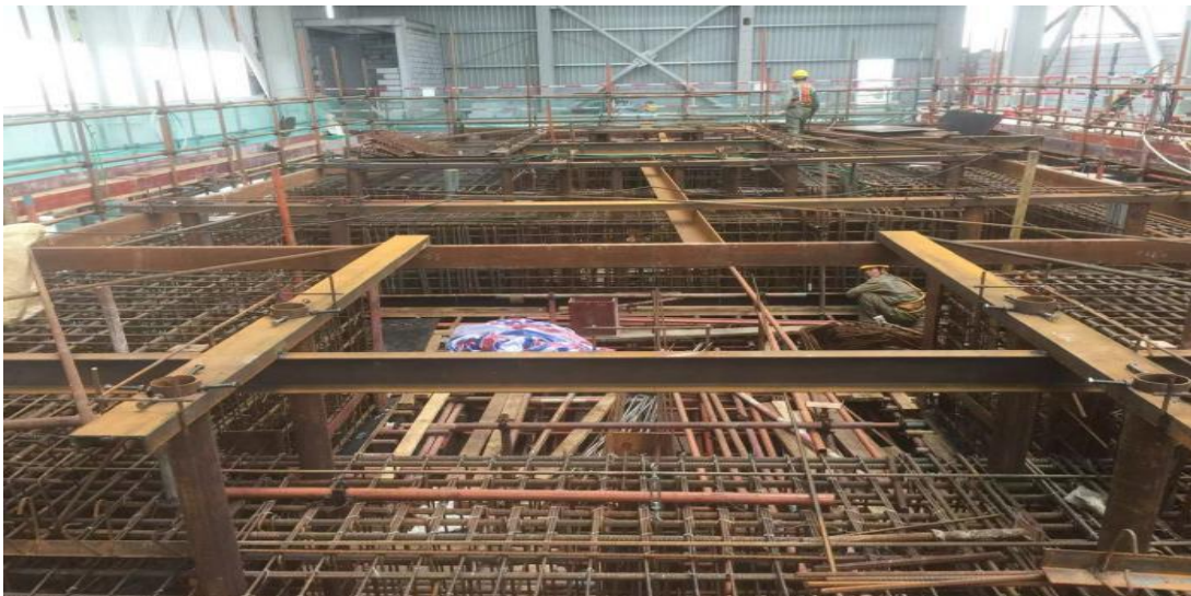
#2 汽機基座埋件安裝完成
