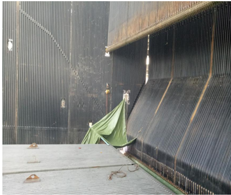
鍋爐房受熱面焊接安裝
