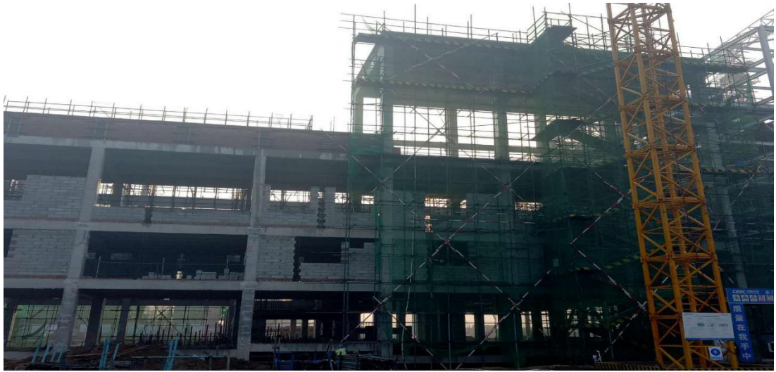
主廠房框架到頂
